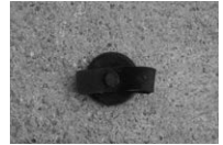
Messdübel in Bohrung einführen und Kappe schliessen
