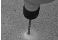
Loch mit Hilfe eines 8 mm / 5/16 in Bohrers bohren
