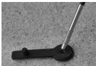
In-Situ Sonde in den Messdübel einführen
