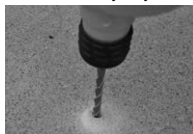
Forare con una punta per trapano da 8 mm
