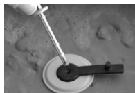
Togliere la barra quando il calcestruzzo si è indurito
