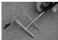
Tagliare il manicotto e la barra conformemente alla profondità di misura
