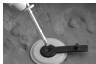
Retirar la varilla después de que el hormigón haya fraguado
